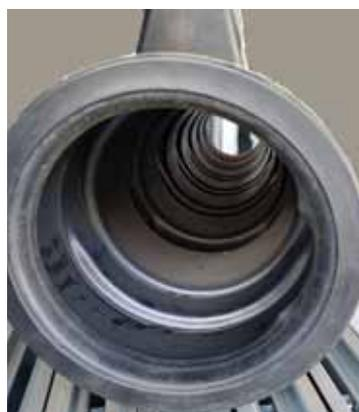
**Рис. 1.** Трубопровод системы АСО Qmax при отсутствии заиливания
